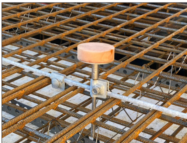
Kontaktplattan monterad innan gjutning.
