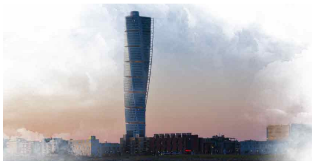
Färganpassat åskledarsystem, potentialutjämnings-system, överspänningsskydd samt UPS.
