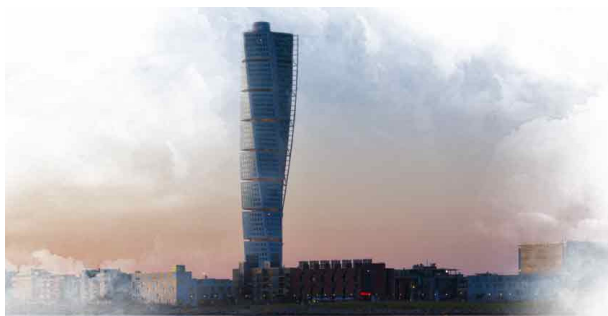
Färganpassat åskledarsystem, potentialutjämningsystem, överspänningsskydd samt UPS.
