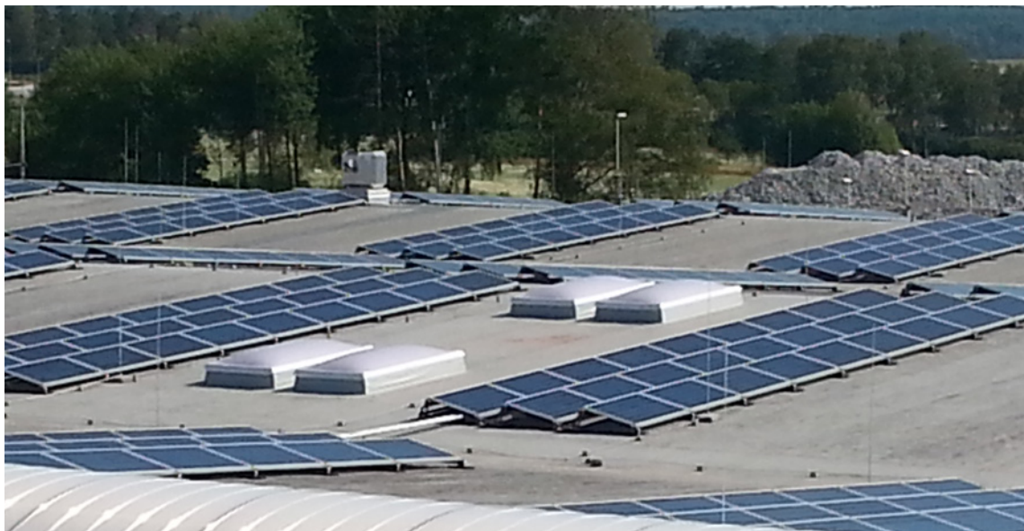
Åskskydd av solpaneler norr om Stockholm.
