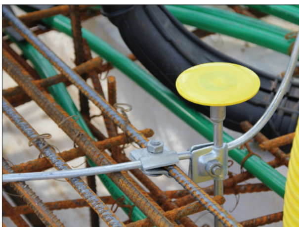
Kontaktplattan monterad innan gjutning.
