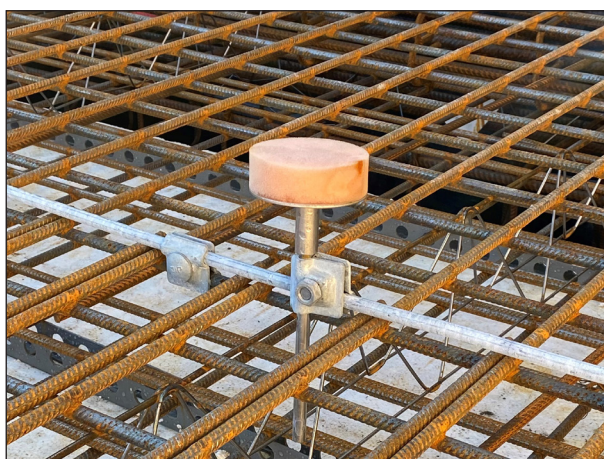
Kontaktplattan monterad innan gjutning.
