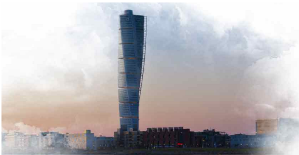
Färganpassat åskledarsystem, potentialutjämnings-system, överspänningsskydd samt UPS.
