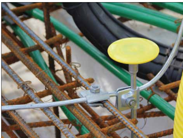
Kontaktplattan monterad innan gjutning.
